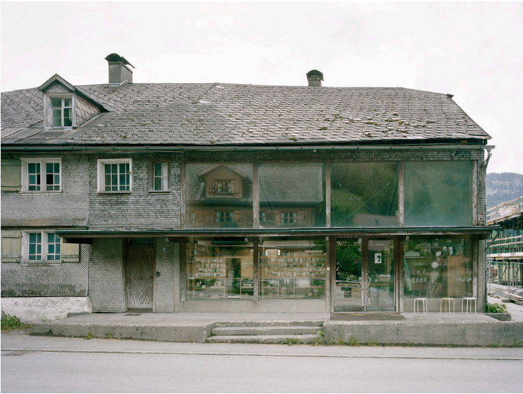
VOR DER REVITALISIERUNG
