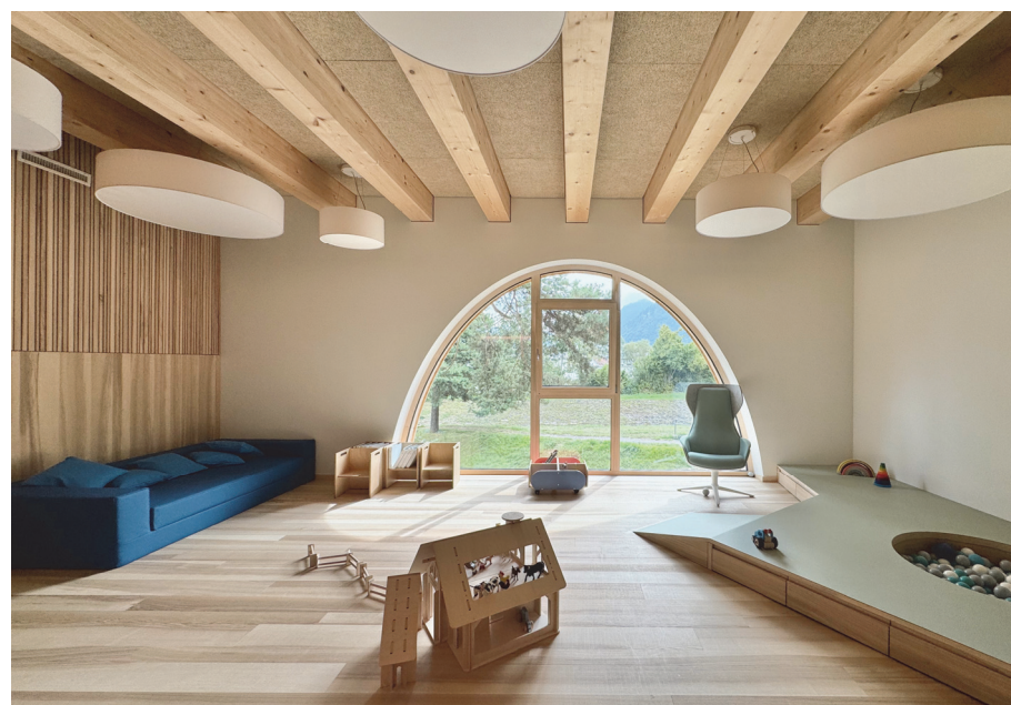
Gruppenraum mit Holzbalkendecke
