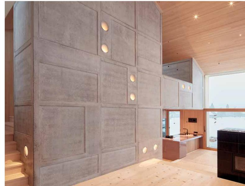
Die Kassettendecke wird neu interpretiert und in Beton gegossen
