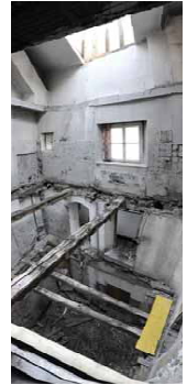
Abbrucharbeiten für das neue Stiegenhaus.
