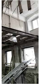
Denkmalgeschützte Decke & Türlwand OG1.
