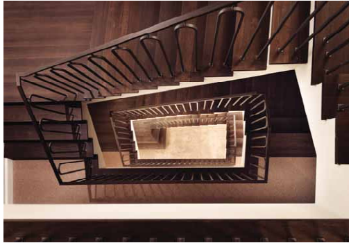
Neu implementiertes Stiegenhaus mit geschmiedeten Geländerstäben.
